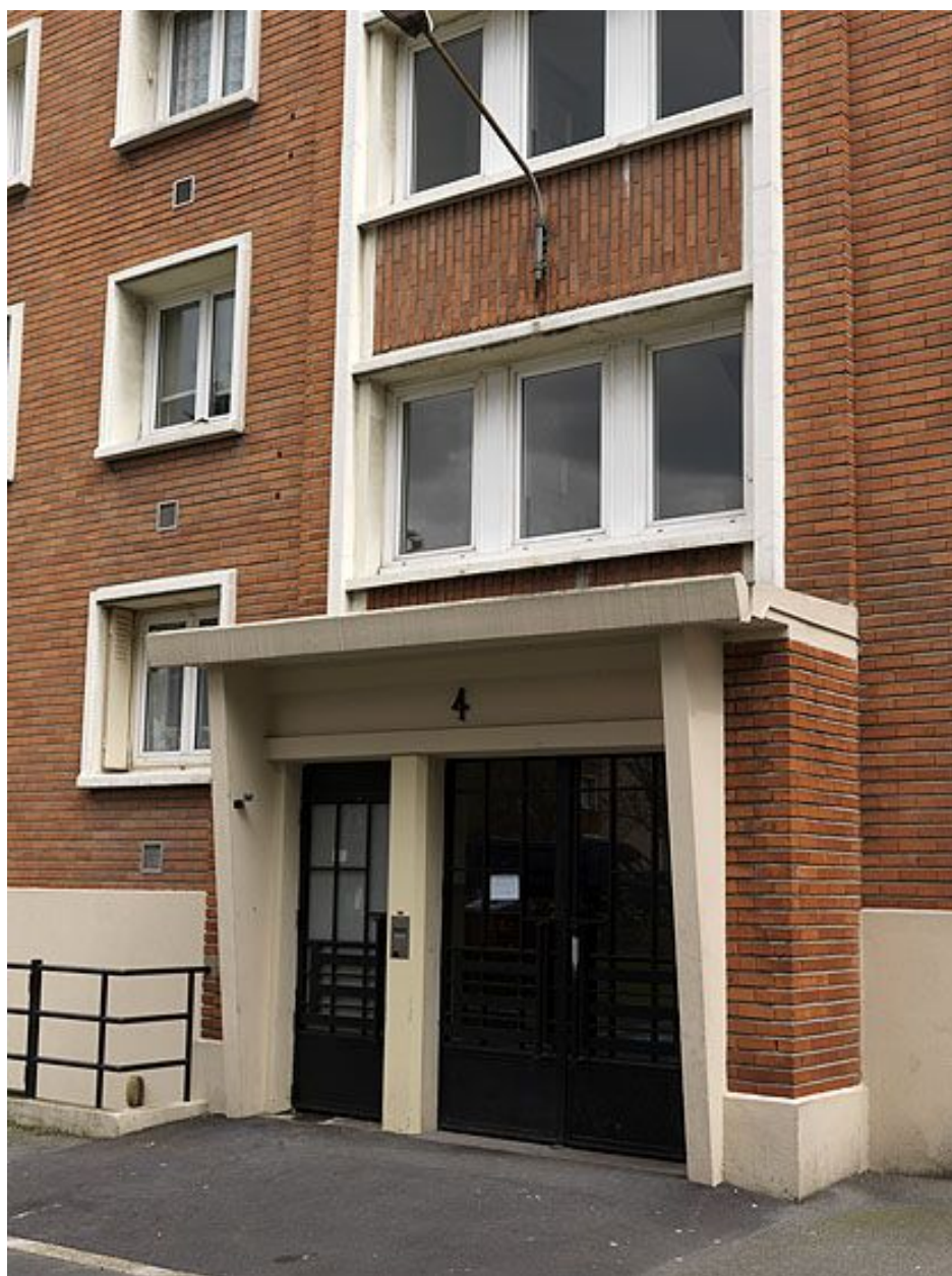
Vitry-sur-Seine, cité dite cité Rosenberg, 101 rue de Choisy. Détail de l'auvent extérieur en béton protégeant l'accès à un hall d'immeuble.
