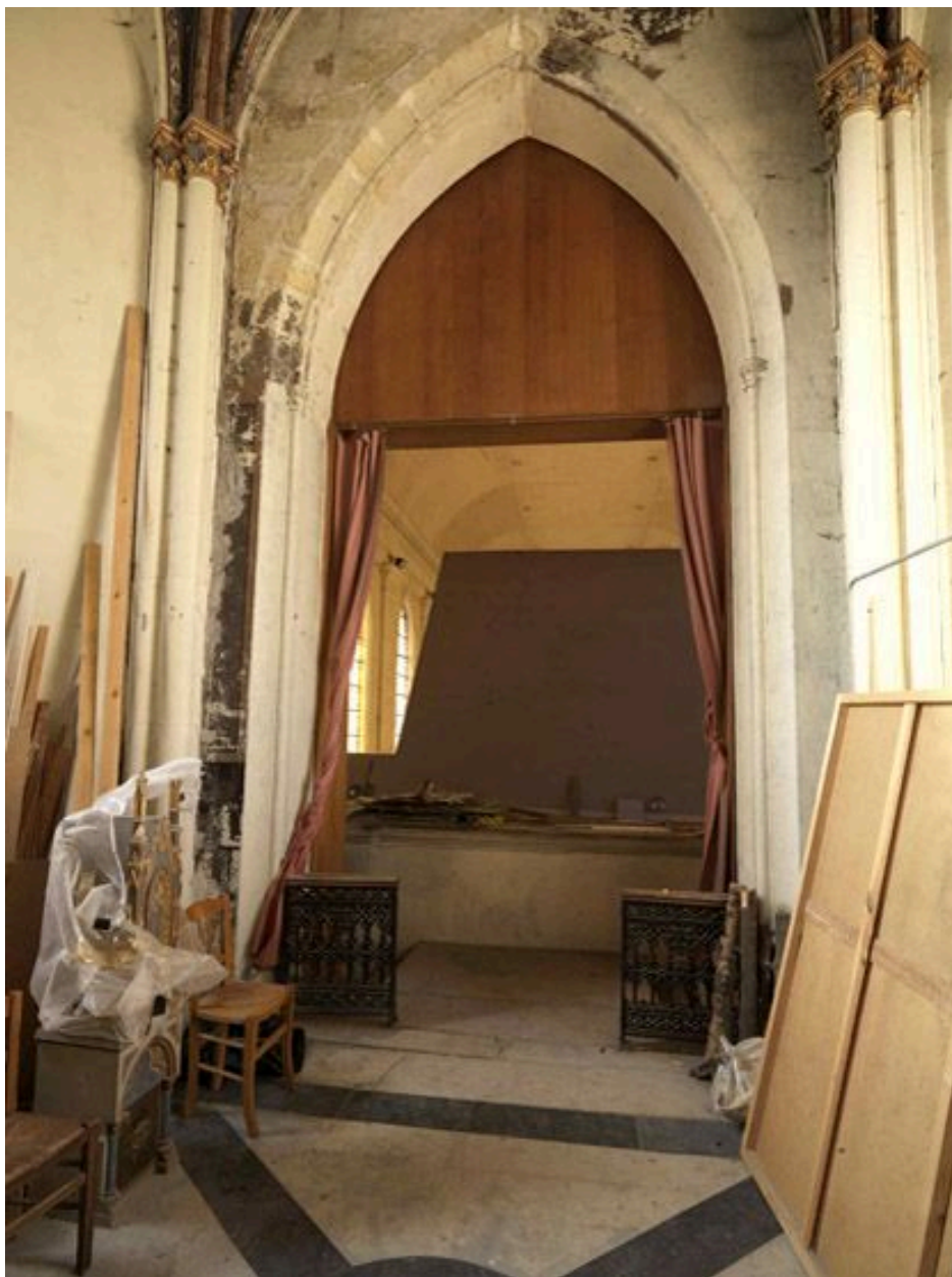
Le mur occidental de la chapelle axiale. Vue prise depuis l'est.
