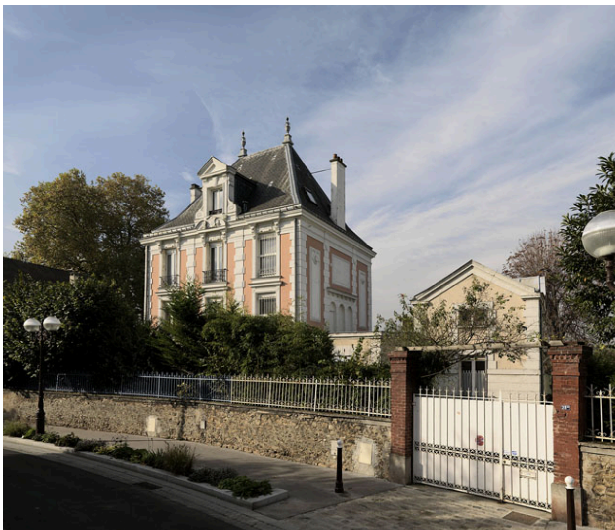
Vue d'ensemble depuis la rue.
