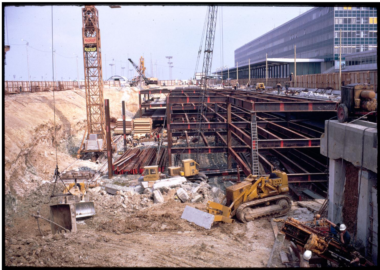
28/04/1968, construction du parking souterrain P1.
