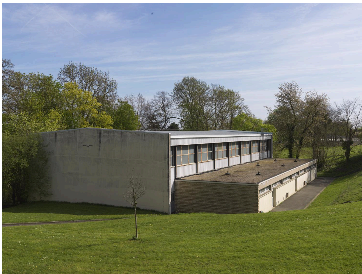
Vue générale du gymnase, situé en contrebas du lycée, à l'est du site.
