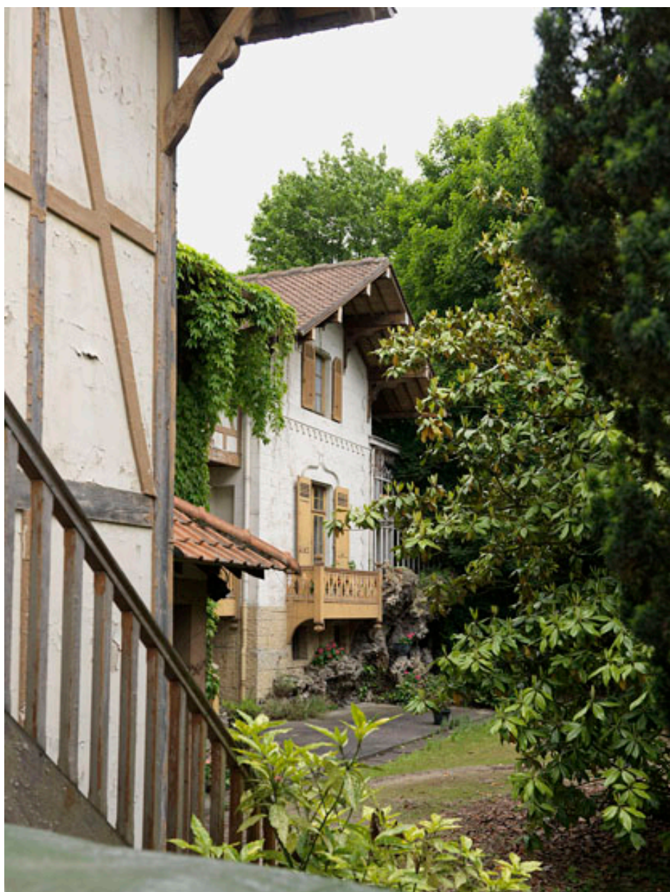
Détail de la façade d'entrée, corps de bâtiment situé à droite.
