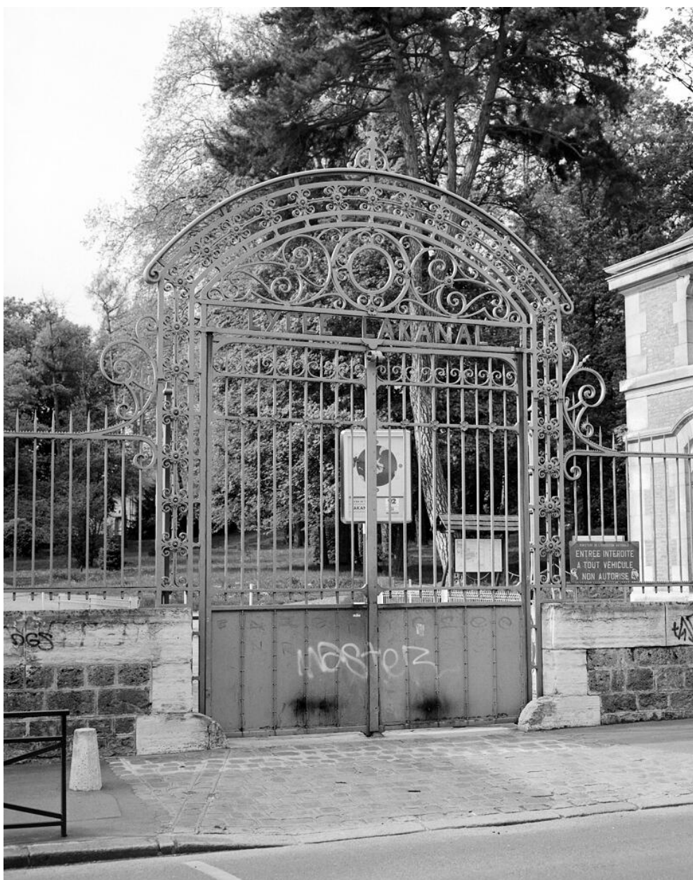
Grille d'entrée. Lycée dit Lycée Lakanal
