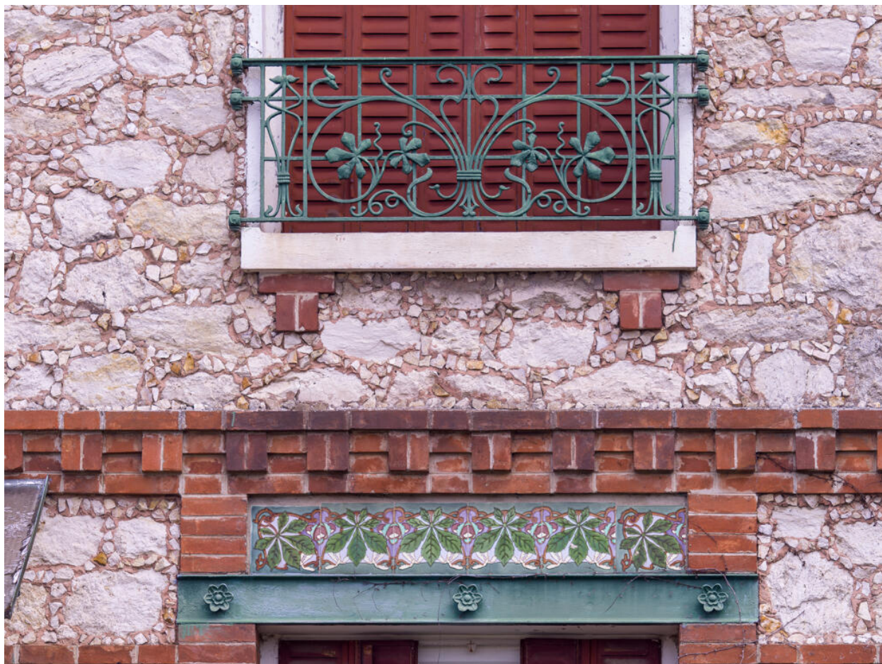
Détail de la façade du 31 rue du Général de Gaulle.
