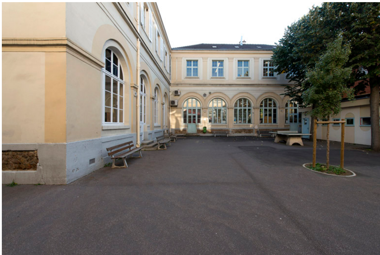
Vue de la cour intérieure.
