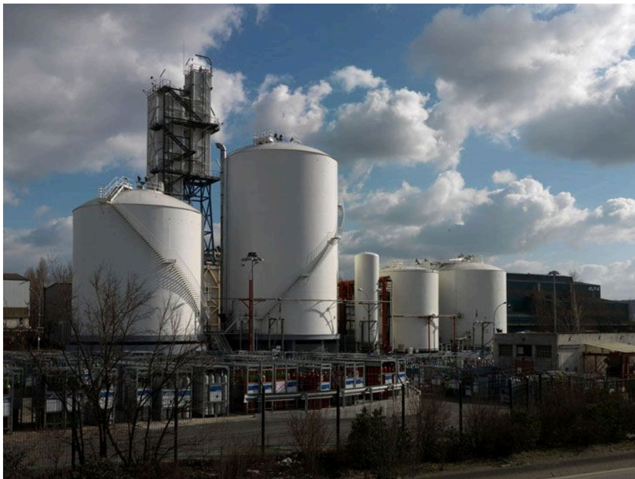
Porcheville, usine de gaz comprimé AGA France, 3 avenue Ozanne. Les cuves.
