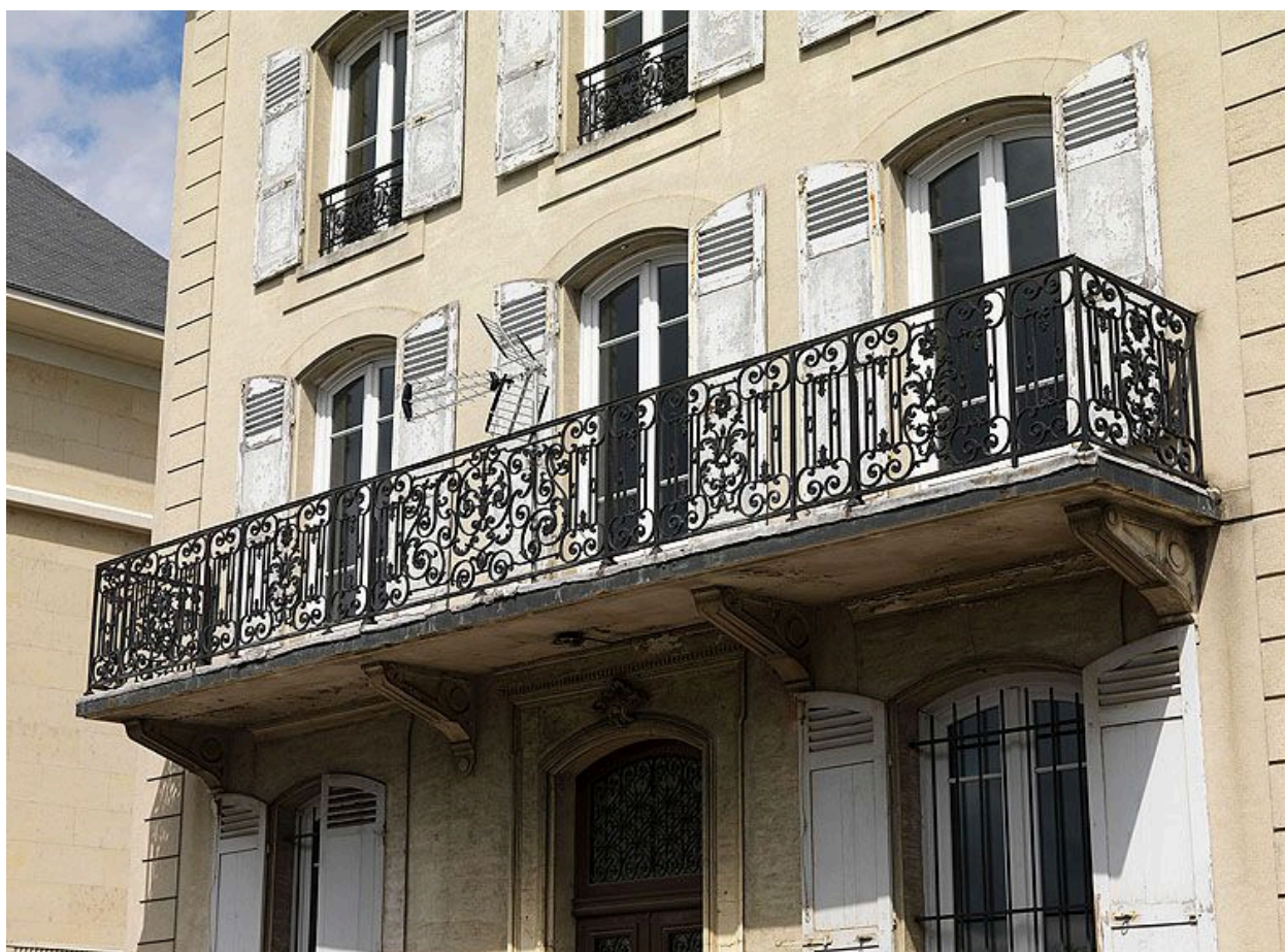
Maison 9 quai Jacques-Prévert : le balcon vers la Marne.
