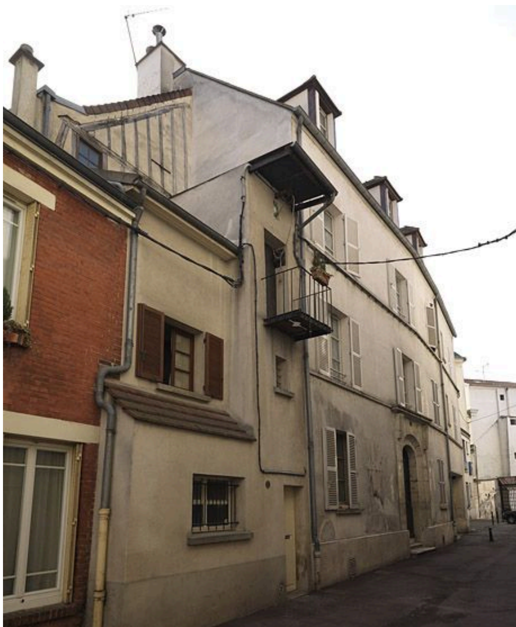
Immeuble 1 rue Antoine-Carro : vue d'ensemble.
