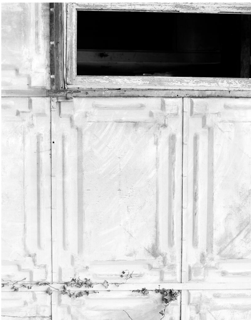
Détail d'un des panneaux métalliques constituant la façade (état en 1991).
