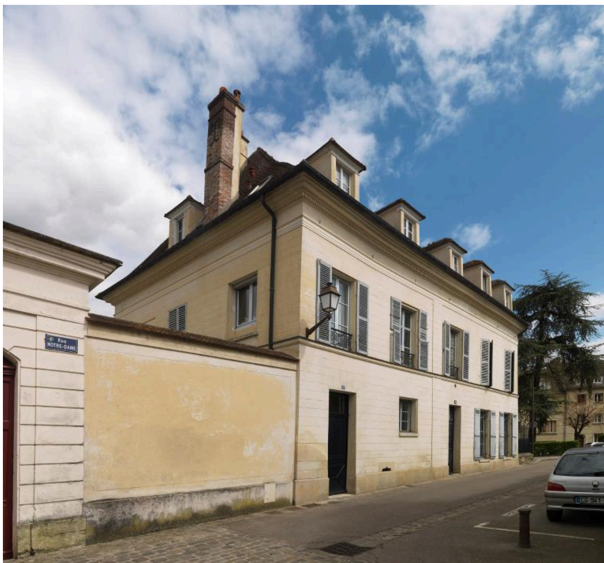
Vue de la façade sur rue du côté du portail d'entrée.
