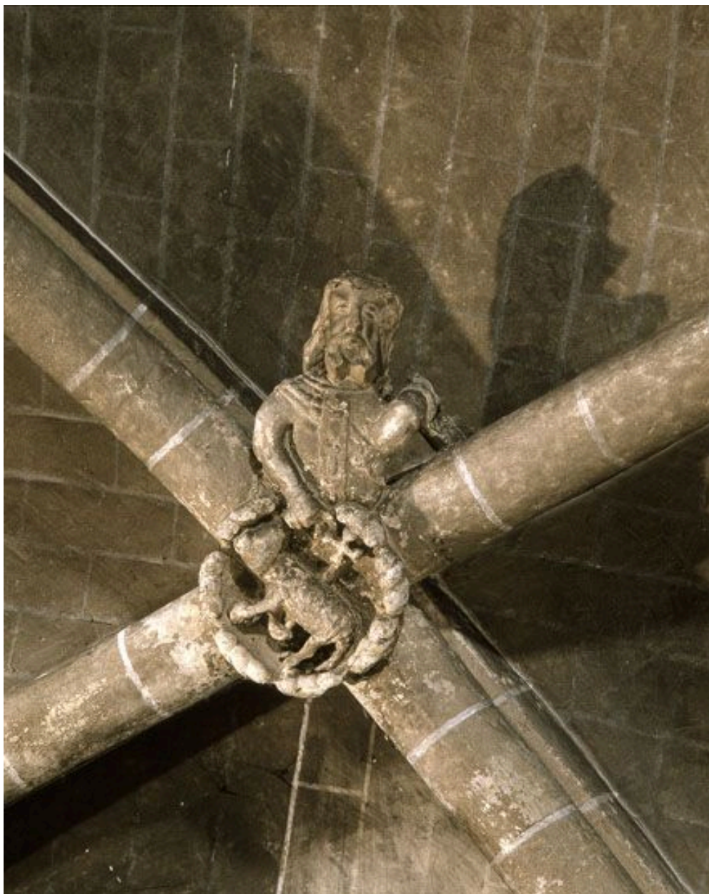
Voûte sur croisée d'ogives de la première travée du bas-côté sud : détail de la clé.
