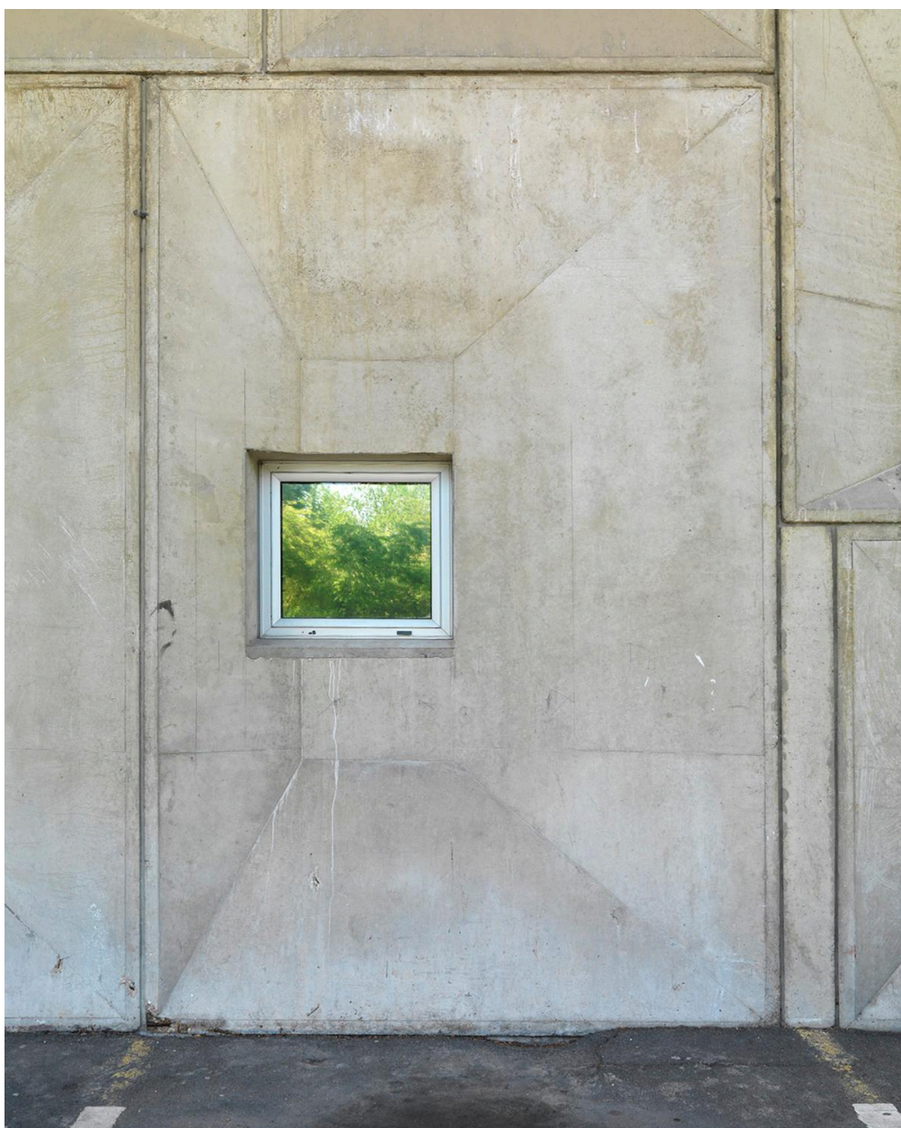
Détail d'une fenêtre de la façade nord-est de la piscine olympique de Colombes.
