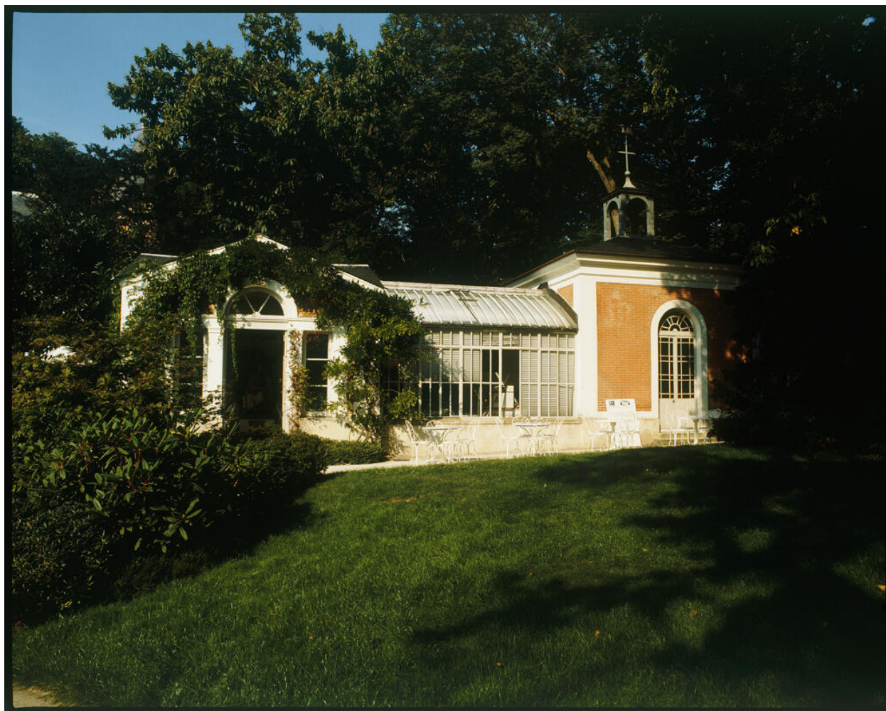
Façade nord de l'orangerie et de la chapelle. Leur construction est datée de 1860.
