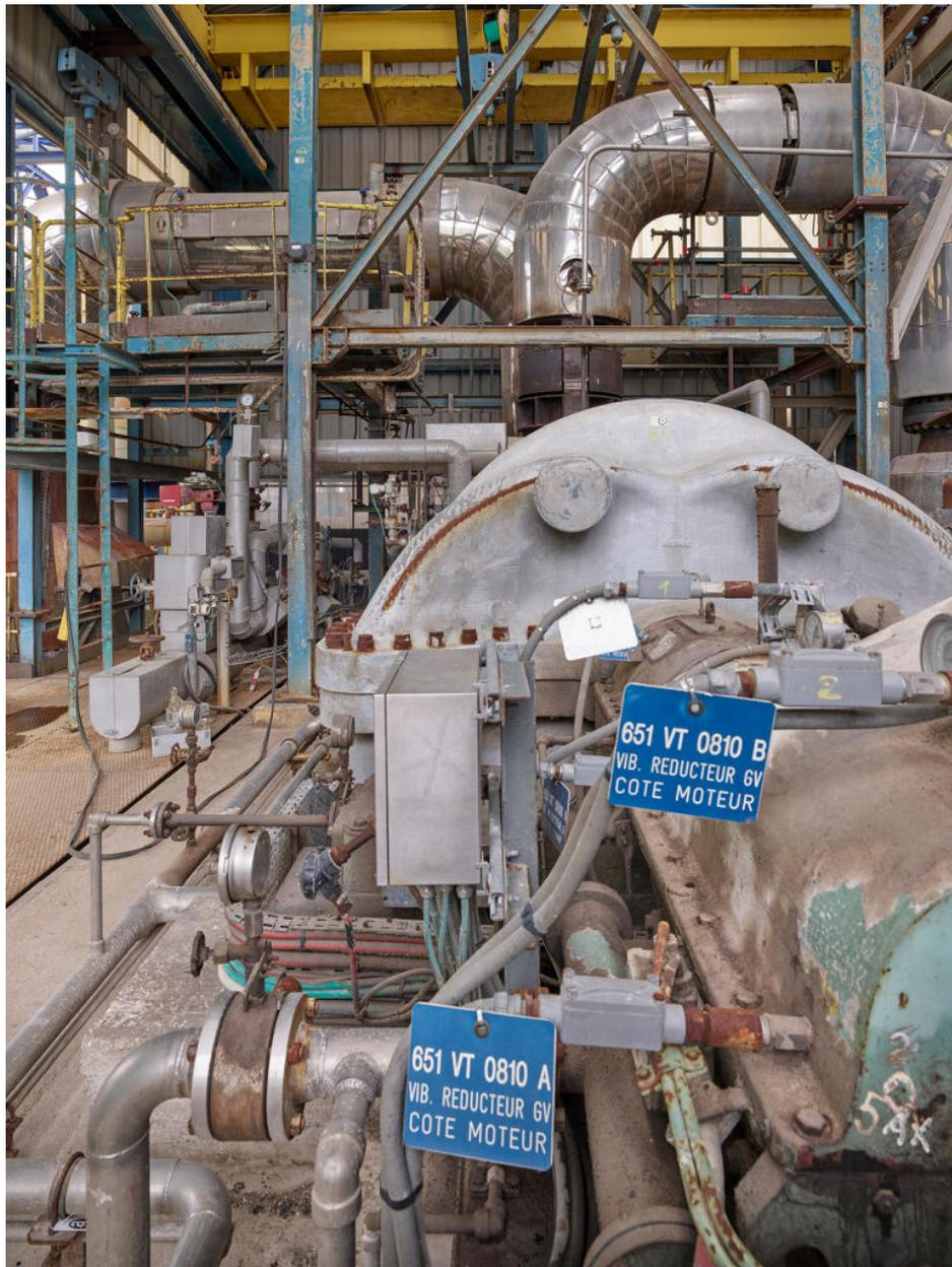
Unités Est - Zone FCC (Unité 651). Compresseur turbo-alternateur, autrement dit compresseur à récupération d'énergie.
