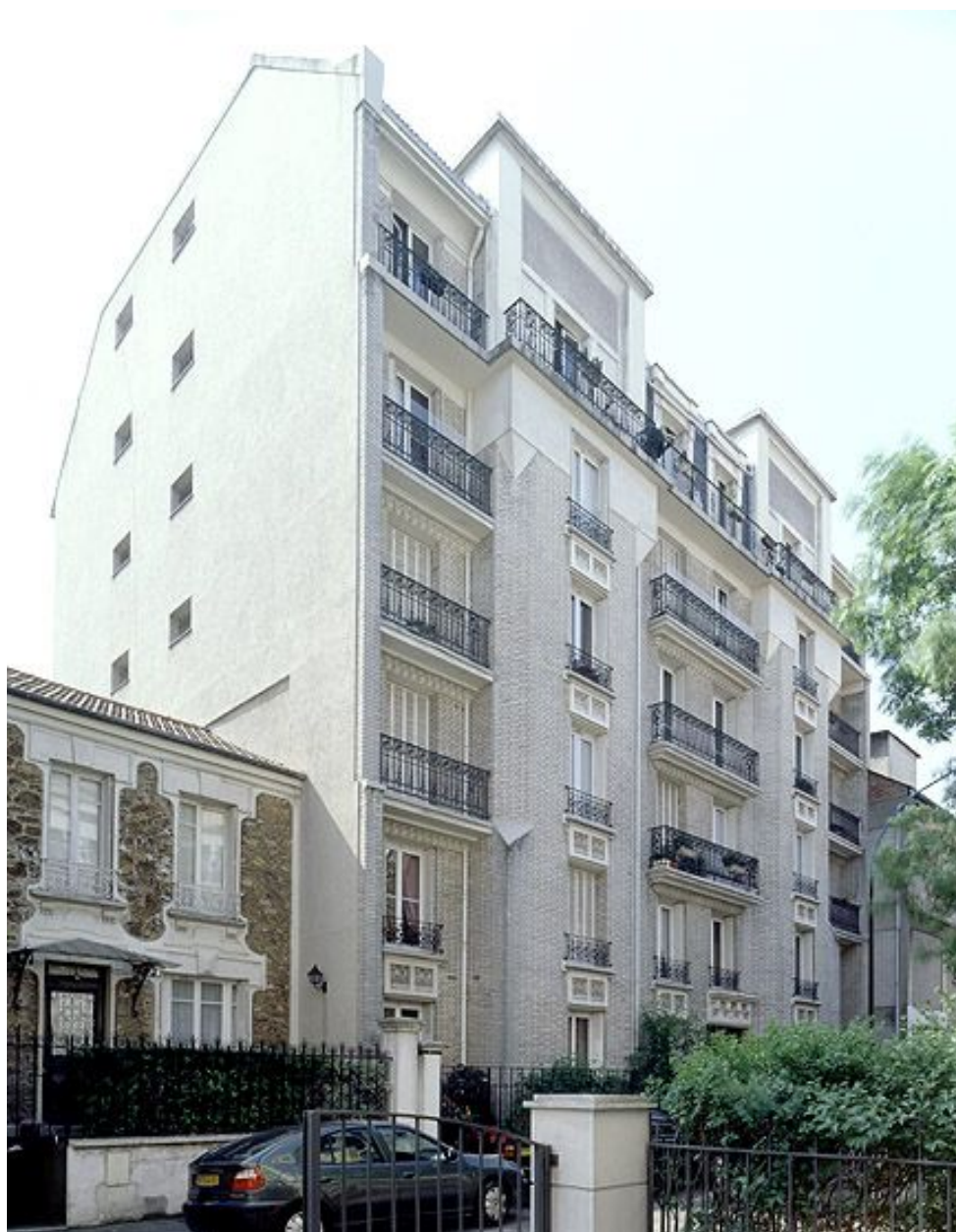
Vue d'ensemble de la façade.
