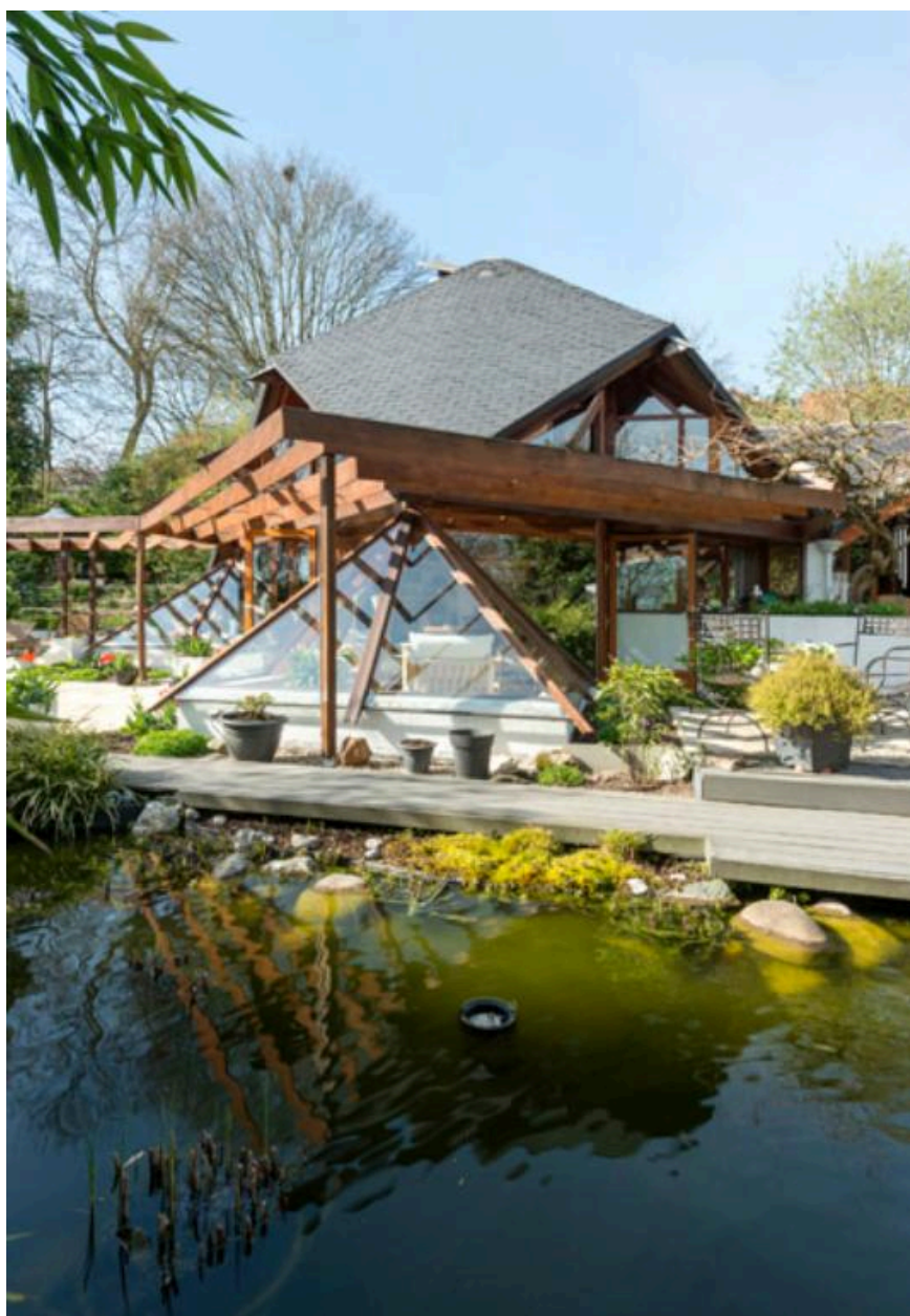
Vue de la façade principale : détail de l'avant-corps Ouest et d'une de ses pergolas.
