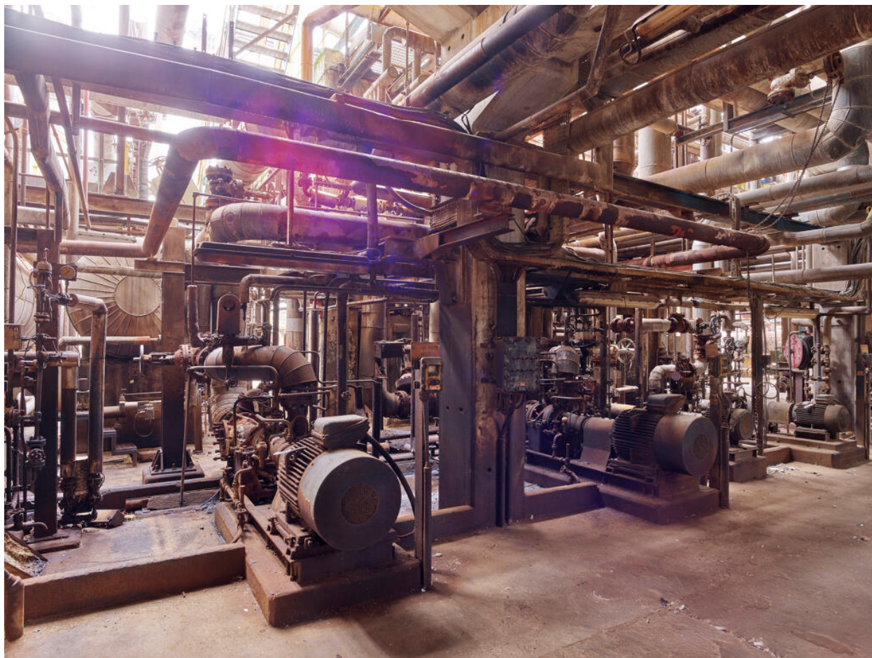
Unités Est - Zone FCC (Unité 651). Pompes utilisées pour transférer un produit d'une capacité à une autre.
