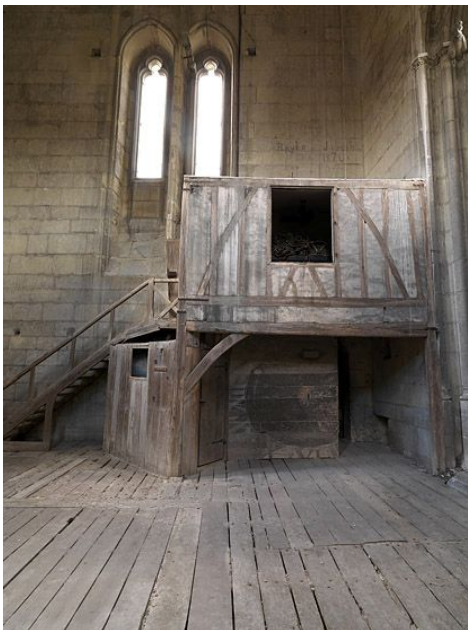
Tour nord, 2eme étage, vue intérieure de la partie sud. La construction en pan-de-bois abrite le mécanisme de l'horloge (voir cliché 20097701276NUC4A).
