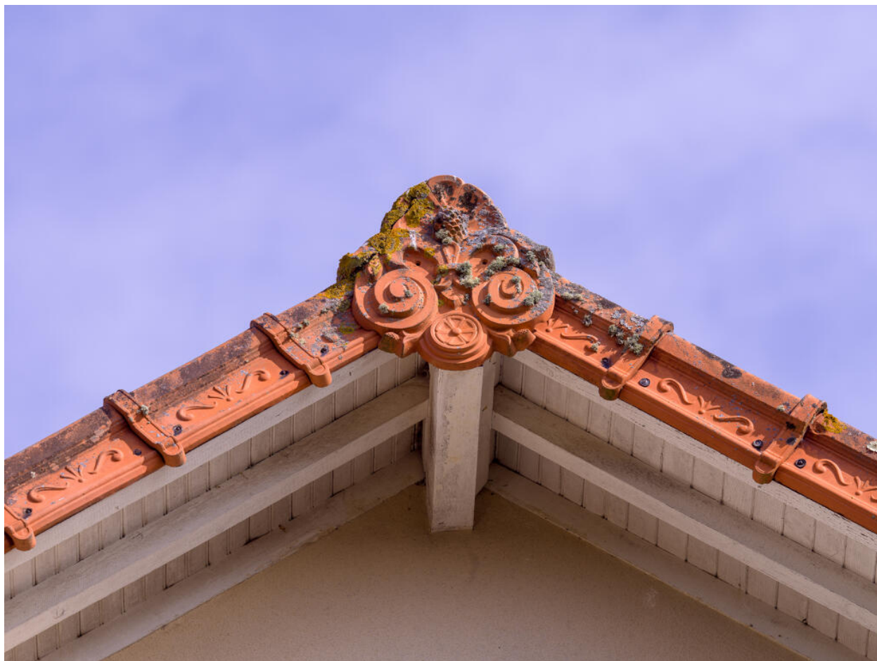
Vue de détail de la tuile faîtière de rive.
