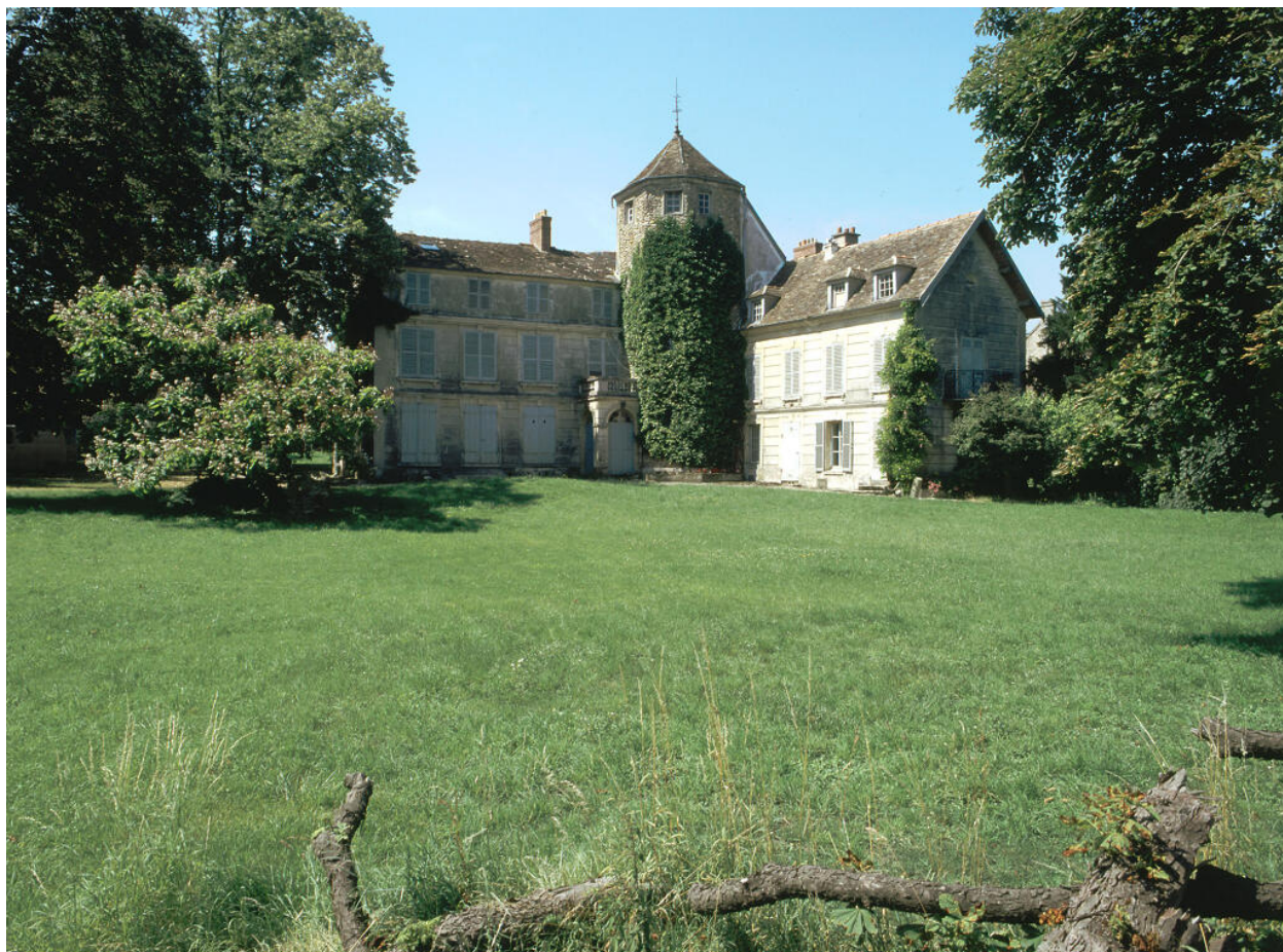
La façade postérieure.
