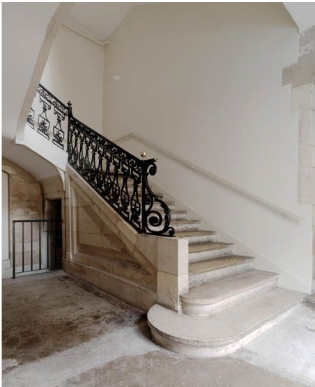
Vue d'ensemble du départ de l'escalier.
