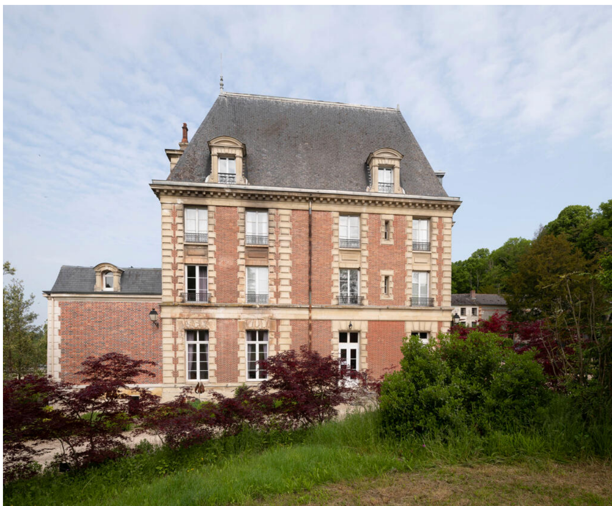
Façade latérale, est.
