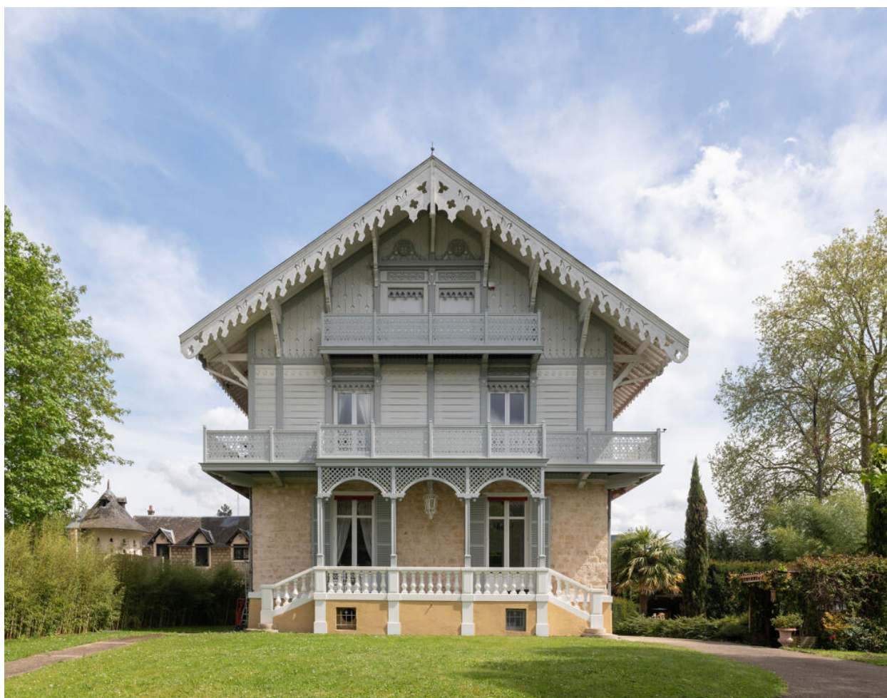
La façade principale.
