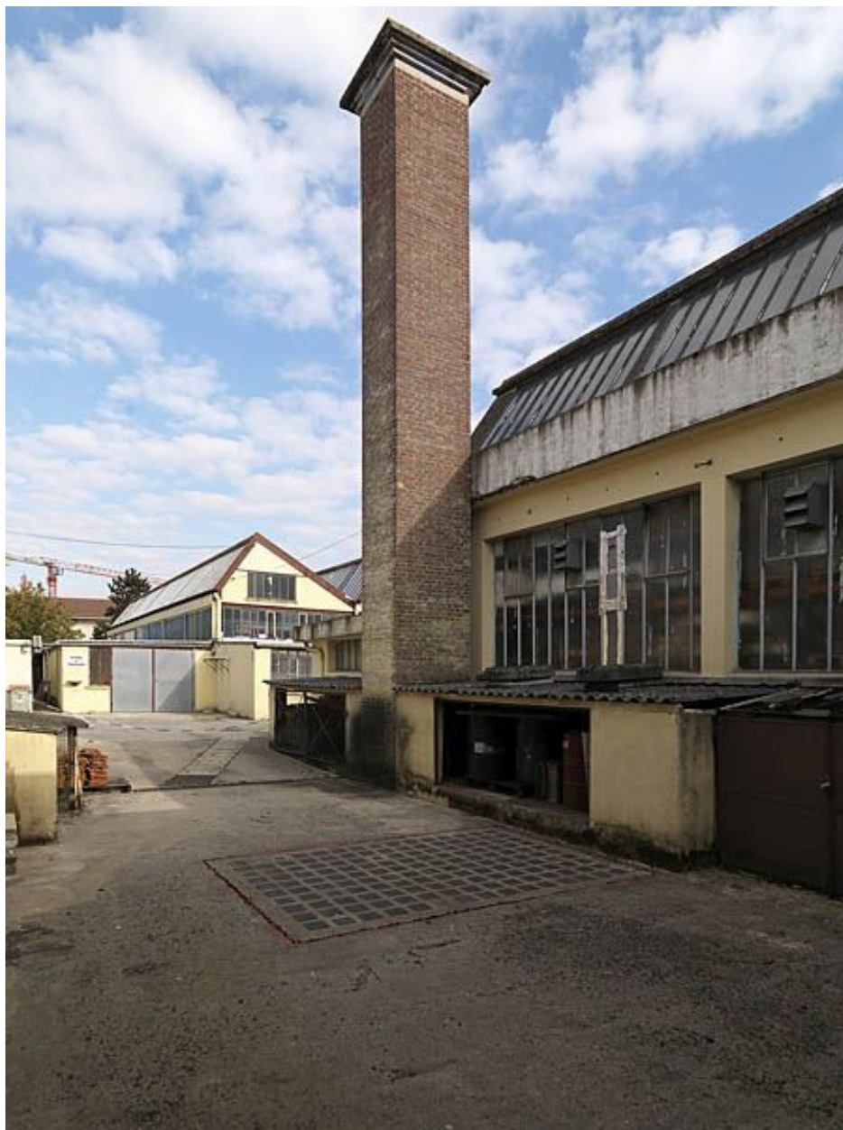
Cheminée de la chaufferie et accès aux caves. Trappe à charbon et sol en brique de verre destiné à éclairer la cave.
