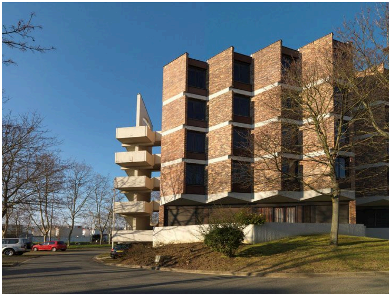
Vue de la façade de la partie hôtelière.
