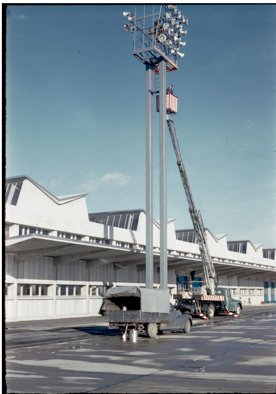
1961, gare de fret, entretien des projecteurs pour les aires de stationnement des avions.
