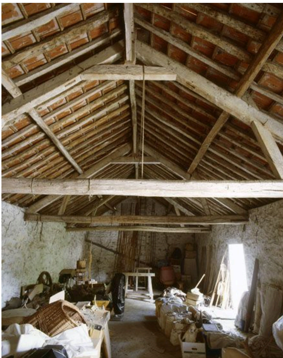
La charpente du bâtiment agricole.
