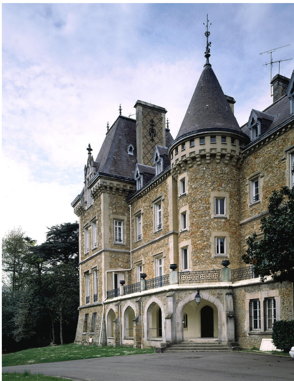
Vue de la façade sur jardin et de la terrasse dominant la vallée.
