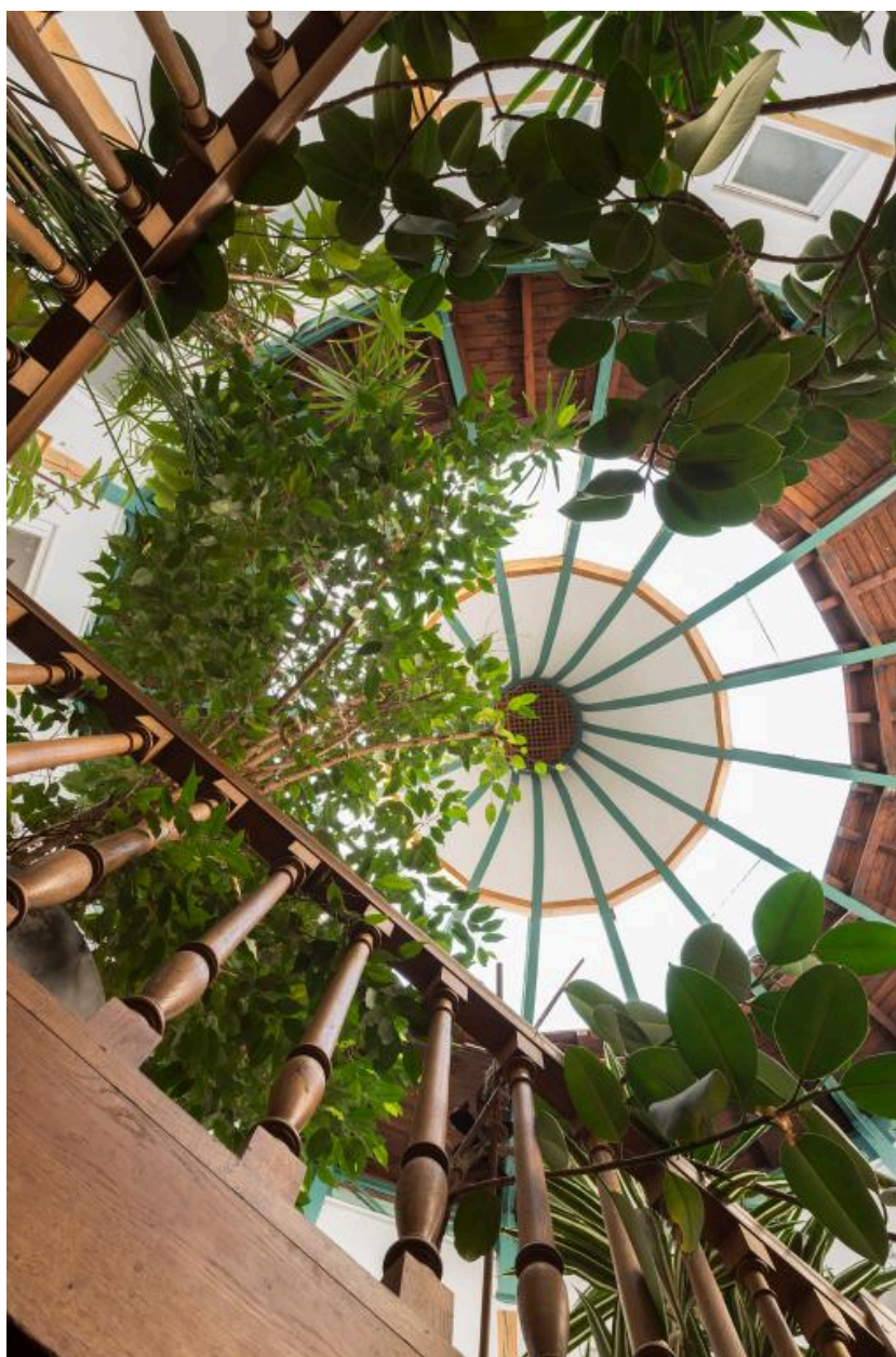
Vue de la charpente métallique de la Rotonde en contre-plongée depuis l'escalier
