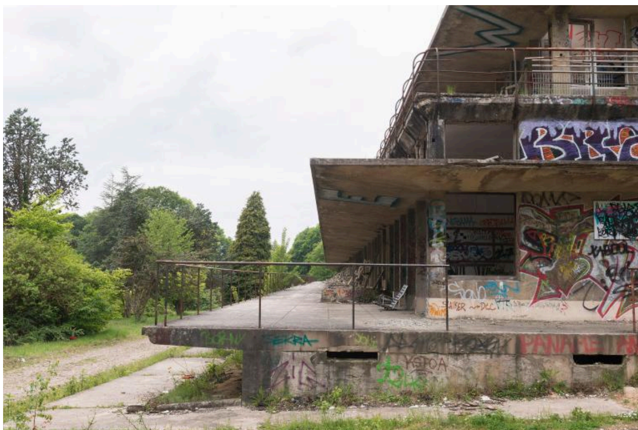
pavillon Bonnefoy-Sibour, façade sud
