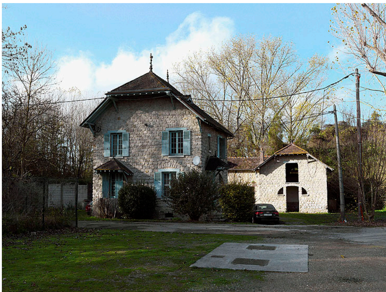
Le pavillon du gardien, à l'entrée du site de Torcy : vue prise depuis le sud.
