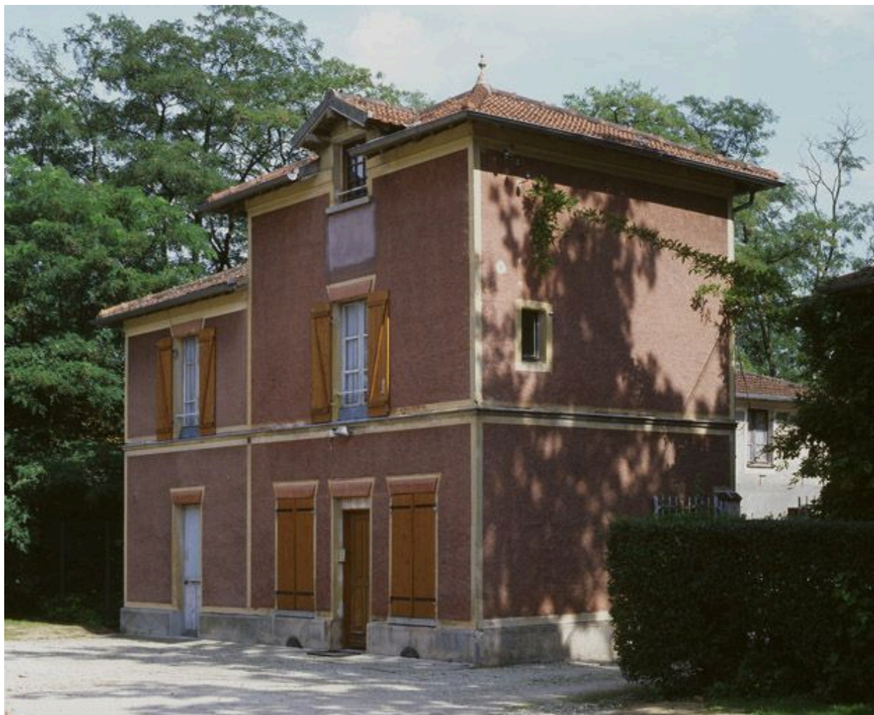
Vue d'ensemble de la maison du gardien.
