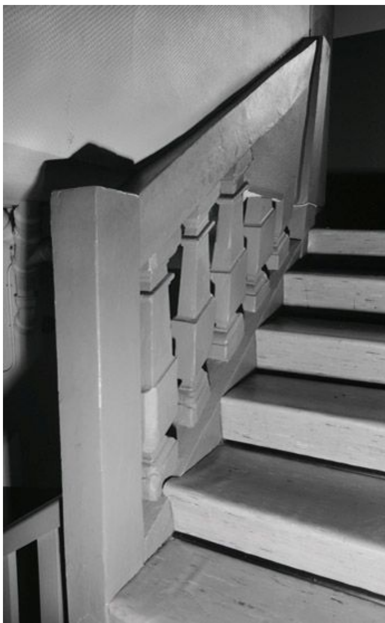
L'escalier à balustres, au dernier étage de la maison.
