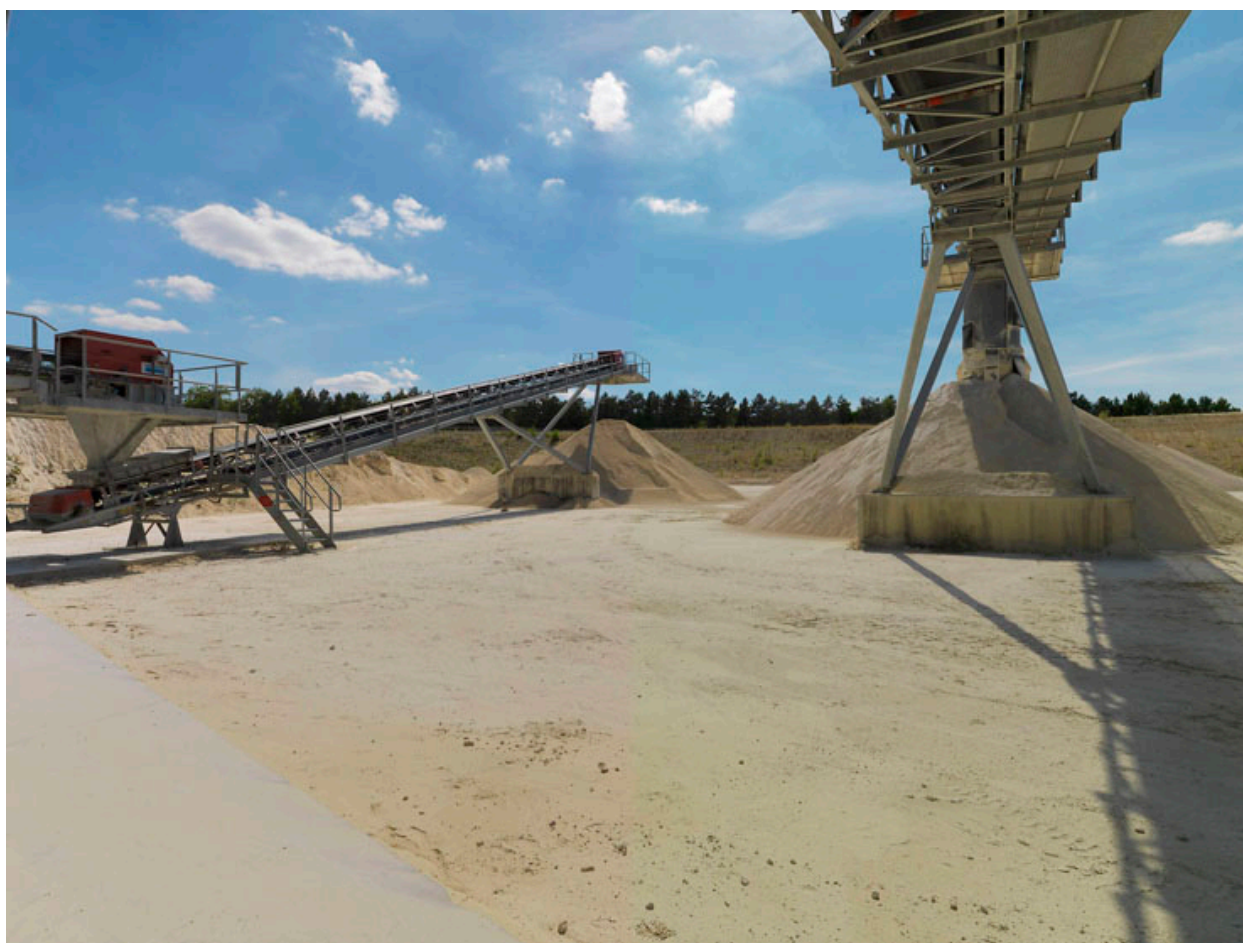
Plateforme - installation secondaire.
