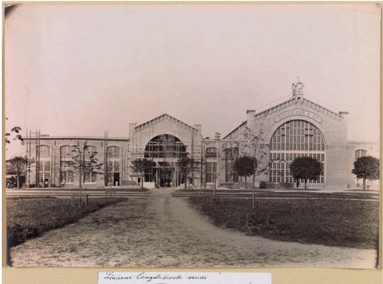
Photo ancienne. Construction de la liaison longitudinale sud, septembre 1917. En façade, le style de Paul Friesé est respecté..
