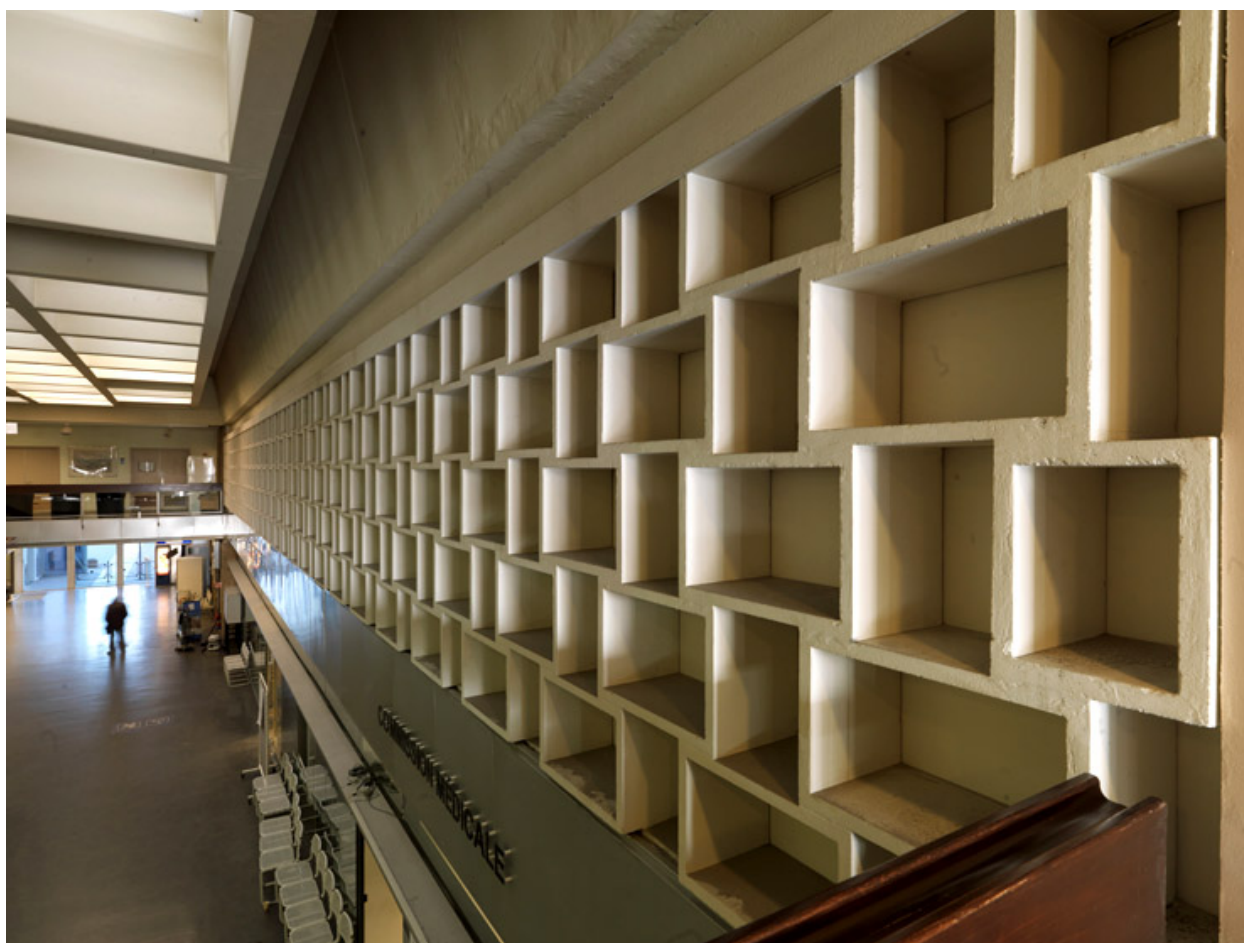
Claustras de béton, au-dessus du hall d'accueil.
