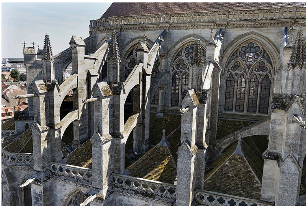
Vue panoramique, prise depuis un ballon captif : fenêtres hautes du choeur, côté nord.
