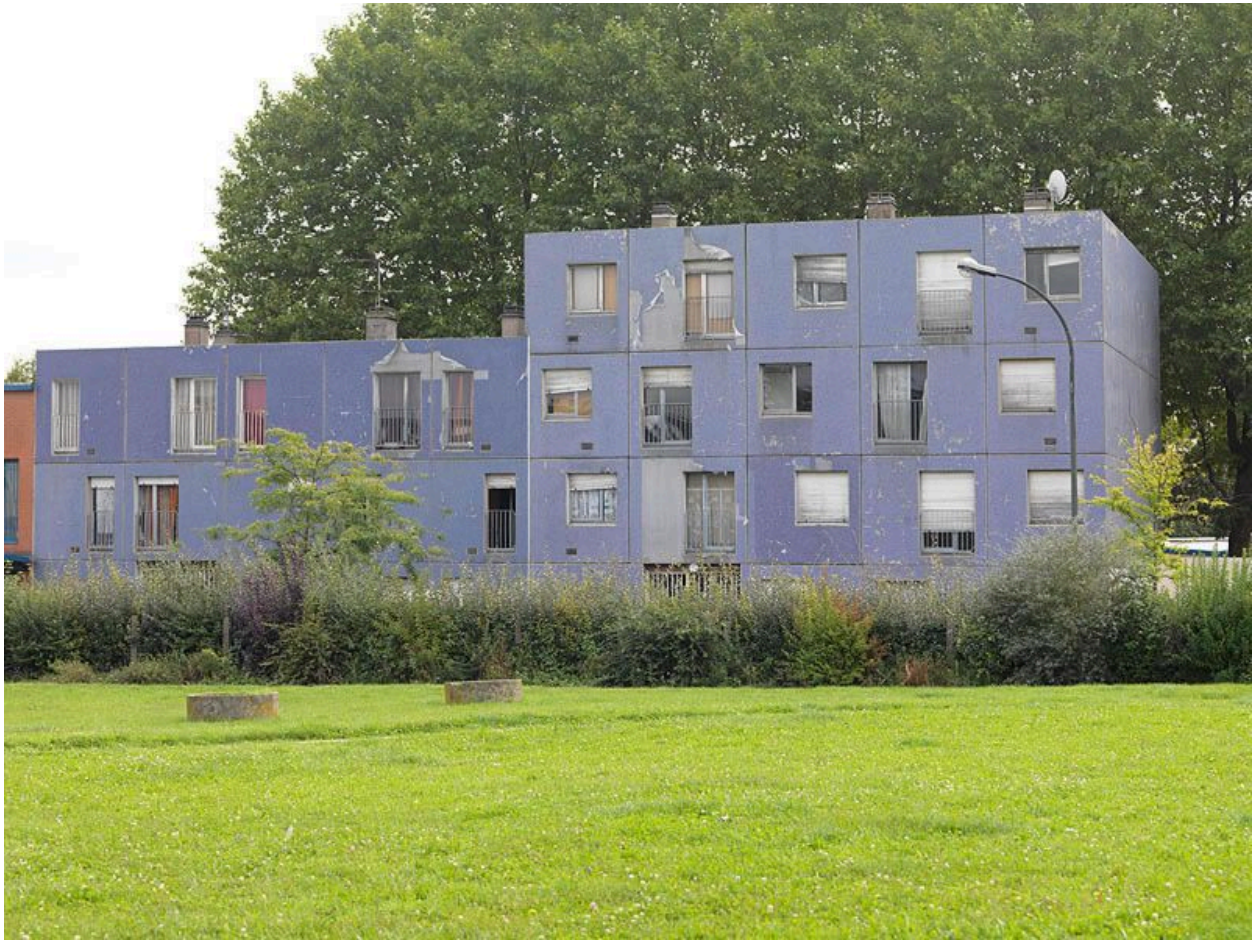
Vue des batiments de l'école rue de l'Autruche.
