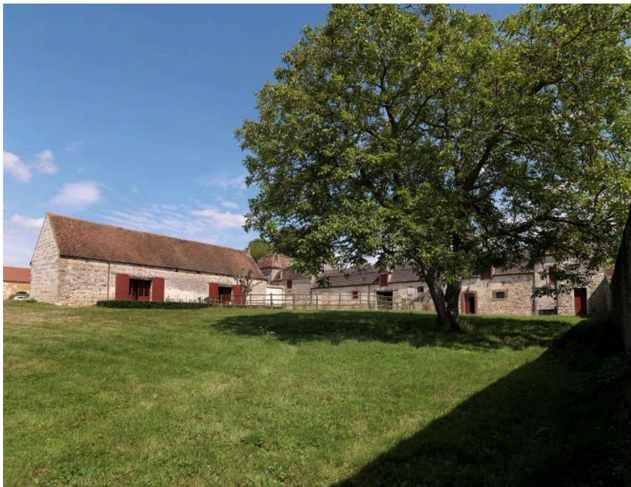
Vue sur le manège depuis le sud-ouest.
