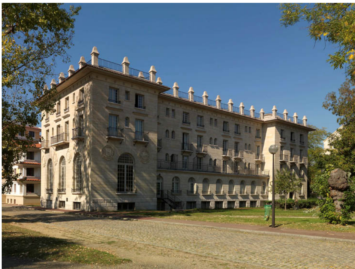
Vue d'ensemble : façades est et sud.
