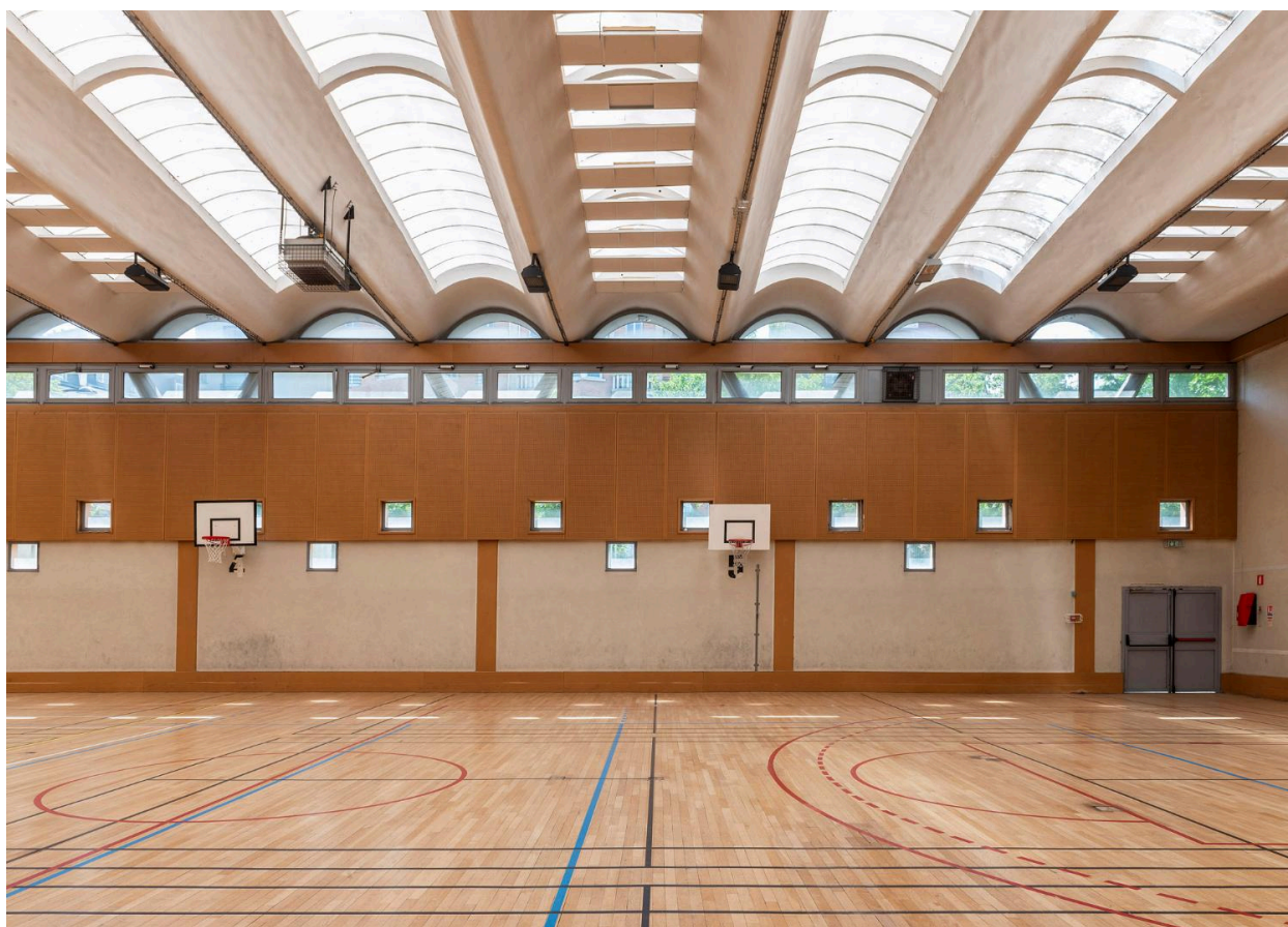
Vue intérieure du gymnase.
