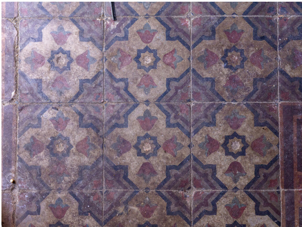
Détail des carreaux de ciment du couloir central du rez-de-chaussée.
