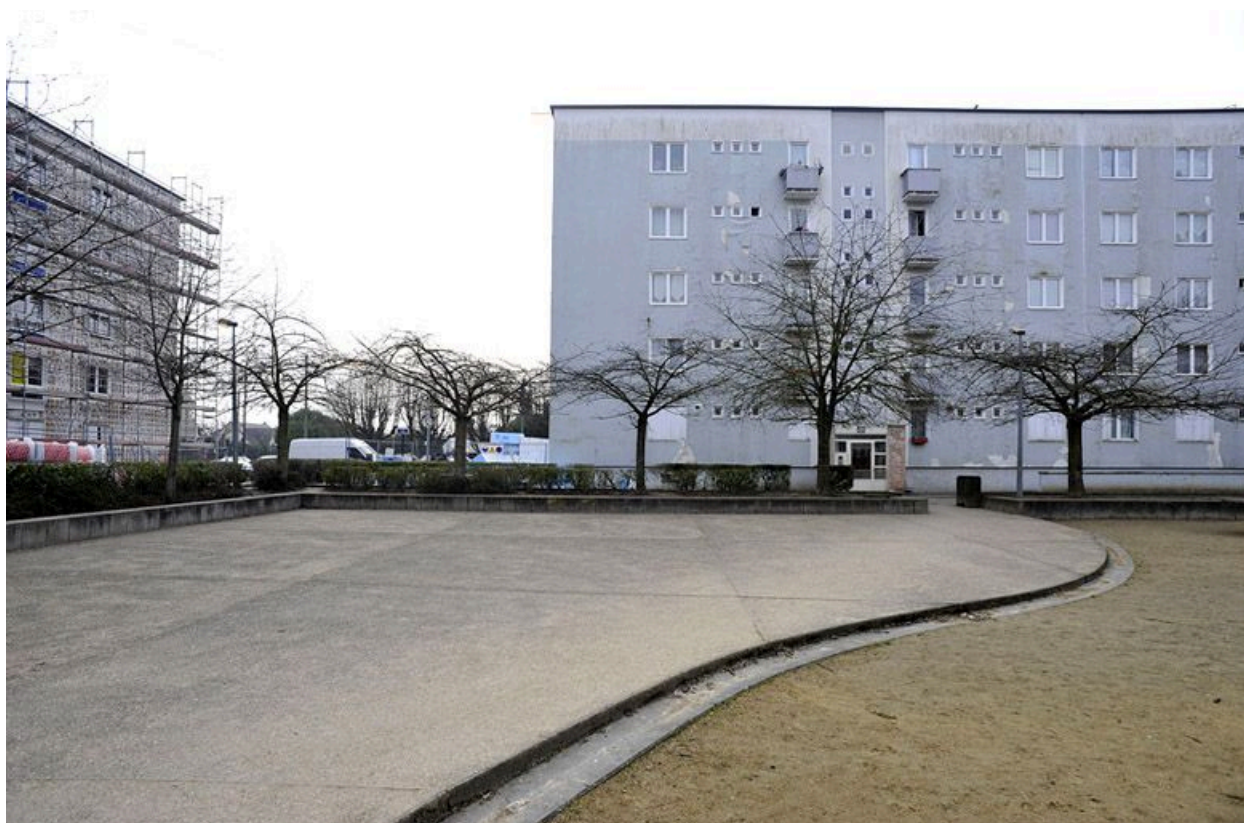
Vernouillet : immeubles du lotissement du Parc en cours de réhabilitation.
