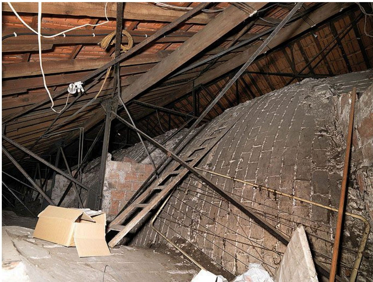
92, Neuilly-surSeine, église paroissiale Saint-Jean-Baptiste, 69 rue de l'Eglise. Extradors des voûtes de brique de la chapelle de l'Annonciation.
