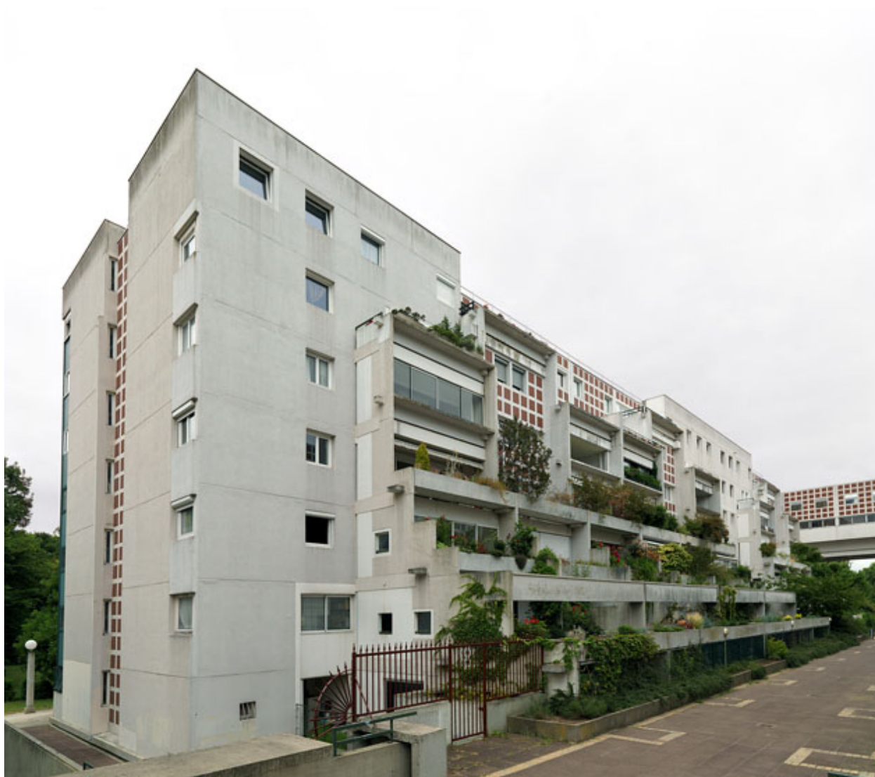
Cité de la Noiseraie, rue de la Butte Verte, Henri Ciriani, 1977-1980. Bâtiment occidental en gradins.
