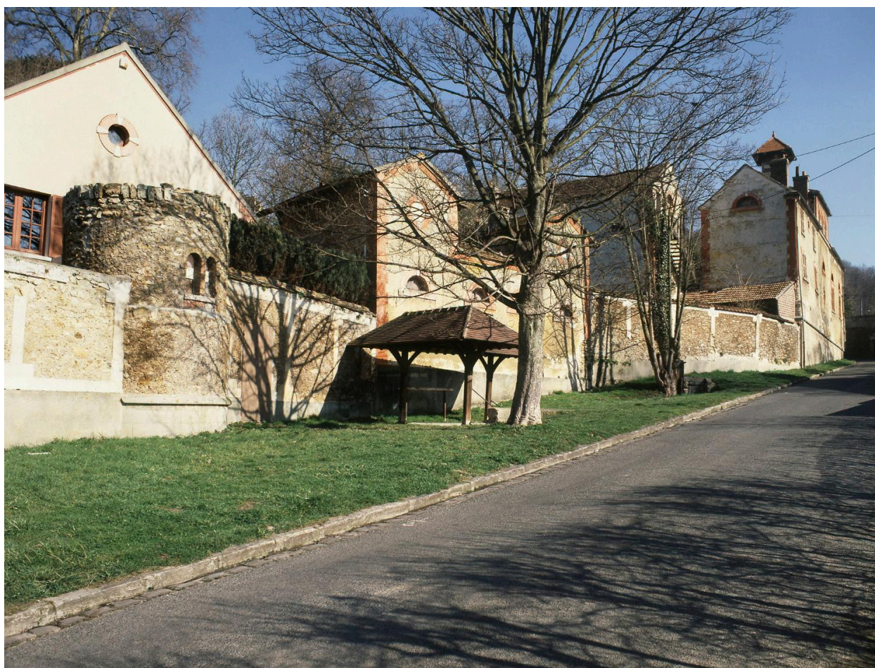
Les communs vus depuis la rue de Vauboyen.
